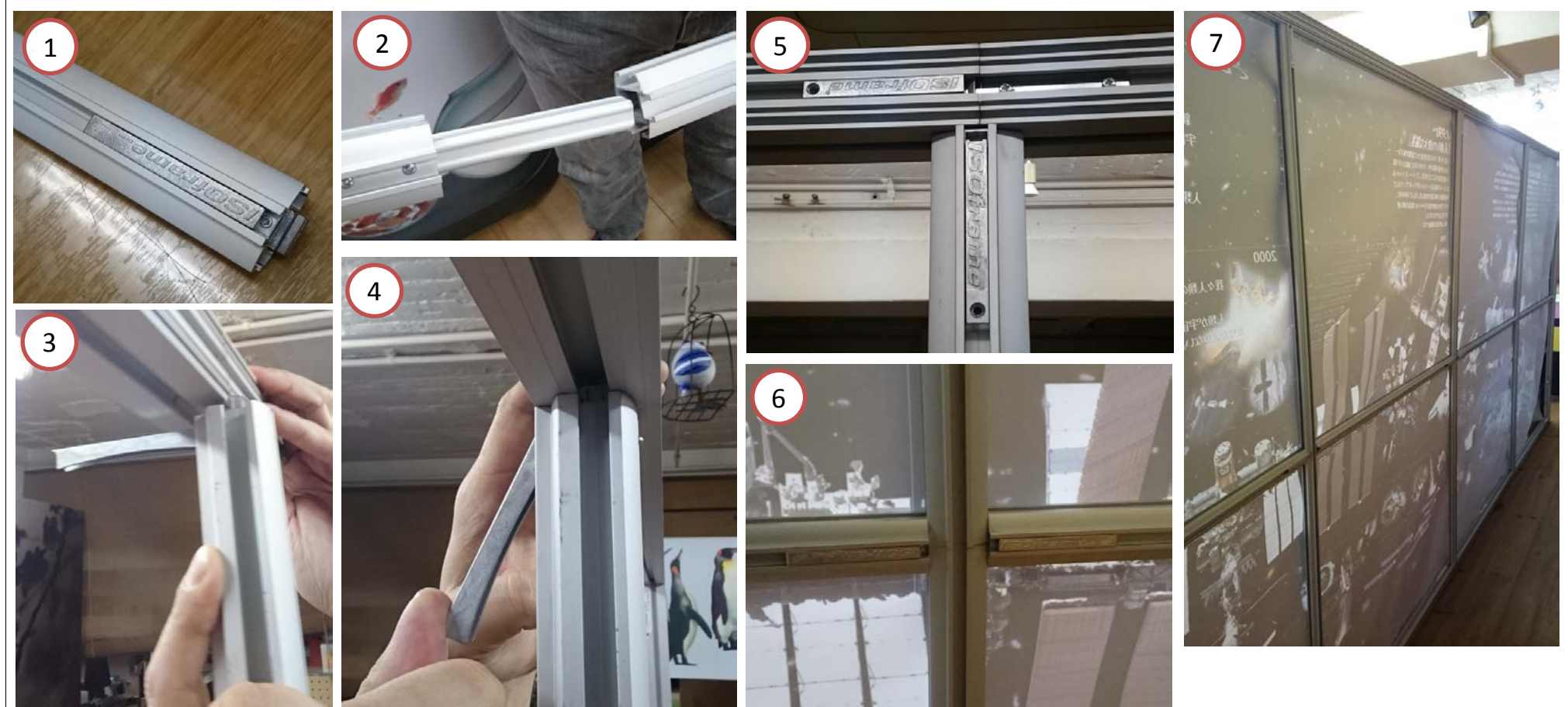
図3、4: 垂直サポートプロファイルは少し斜めにスライドインして、プロファイルの溝に差し込みます。 図5: 垂直サポートプロファイルは上下プロファイルのつなぎ目のセンターに合わせます。 図6: 水平サポートプロファイルは垂直サポートプロファイルのつなぎ目のセンターに合わせます。
