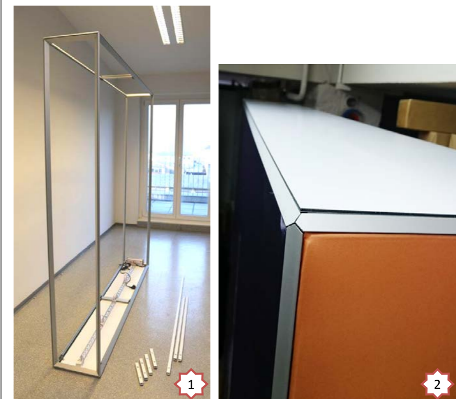
3: 上部フレームを取付けます。
